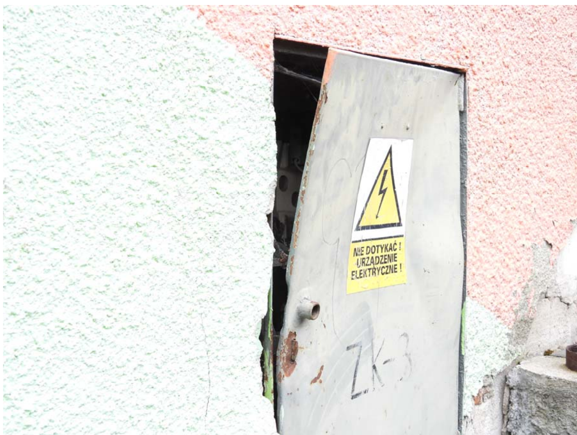
Fotografia 9. GOKiS - elewacja zachodnia (fot. H. Chromińska). Odkształcone drzwi metalowe - potencjalne miejsce gniazdowania ptaków.
